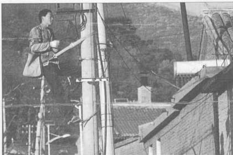
Un trabajador chino arreglando un tendido eléctrico. / ALERTA
